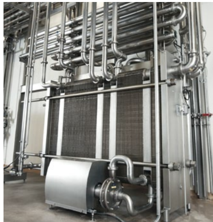
Plattenwärmetauscher VARITHERM® N40, Leistung 24 m 3 /h
