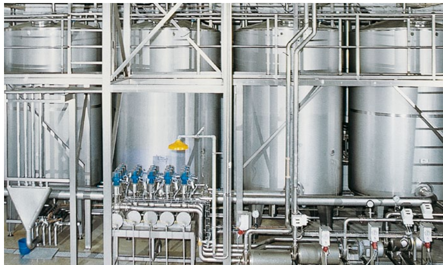
CIP-Stapelreinigungsanlage
