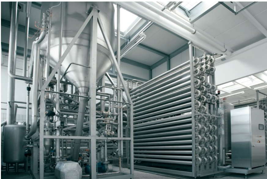
Direkte Erhitzungsanlage. Die Darstellung zeigt Röhrenmodule und Flashkühler.
